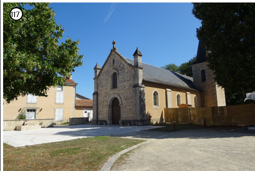
117 Le centre historique de Biard est aujourd'hui cerné de lotissements récents atténuant son influence visuelle. Il n'existe aucun lien visuel entre ce bâti traditionnel et l'AEEM
