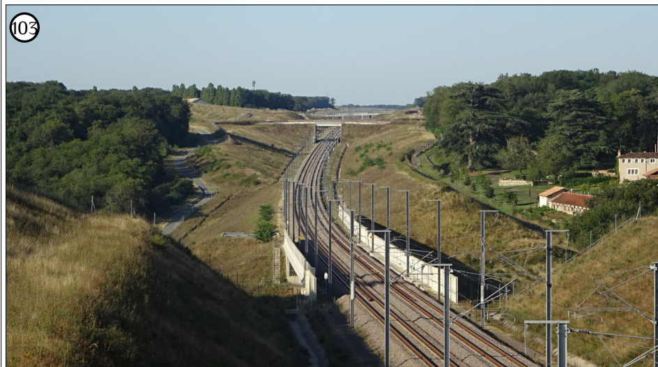
103 Profonde modification de la topographie pour assurer le passage de la ligne LGV conçu en déblai. La lecture de la vallée de la Boivre, coupée ici par la voie, est gommée par les aménagements lourds
