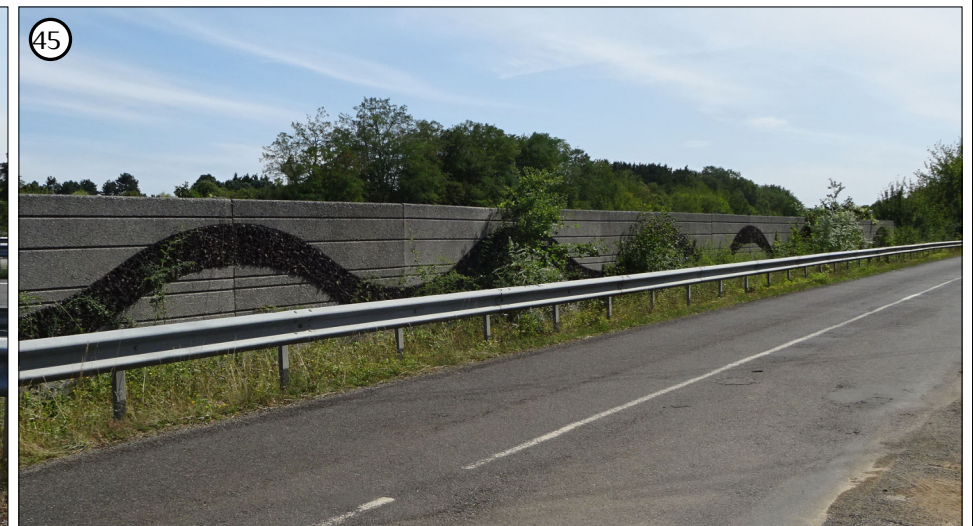
45 Ici, les glissières sont associées à un mur anti-bruit en raison de la proximité d'un lotissement
