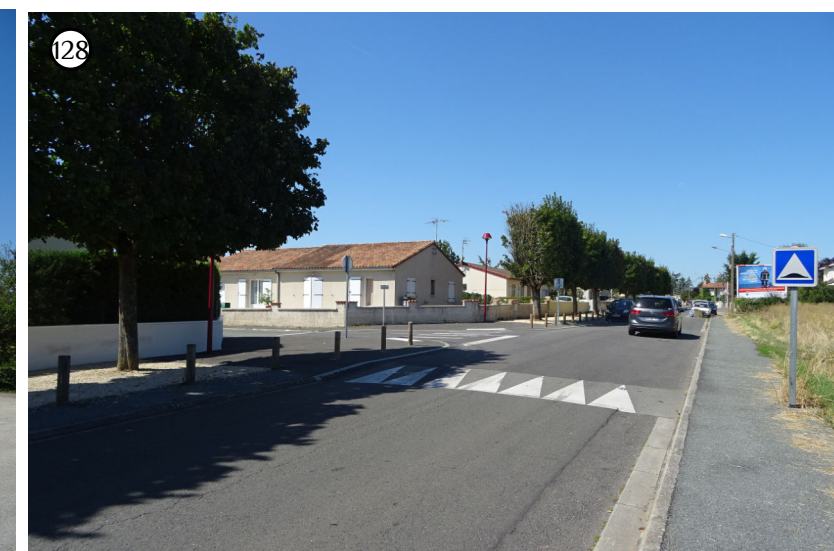
128 La rue Nungesser constitue un axe au Nord duquel quelques fenêtres visuelles s'ouvrent en direction de la zone de projet et cela depuis quelques jardins seulement
