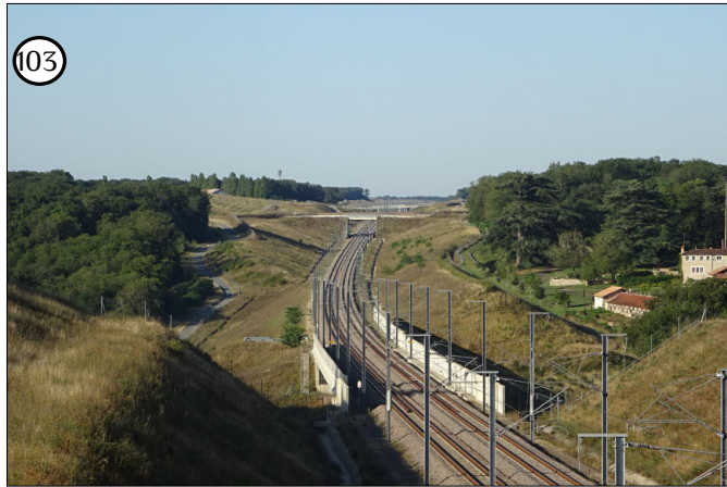
103 Les modifications importantes de la topographie réalisées pour le tracé de la ligne LGV sont nettes sur ce point de vue. La LGV traverse ici la vallée de la Boivre ce qui explique que les talus qui l'encadrent s'abaissent
