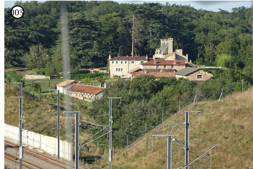
103 Château la Roche en covisibilité avec les infrastructures de la voie ferrée
