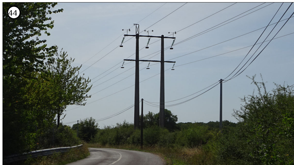
44 Le vocabulaire lié à l'agriculture (rampes d'arrosage, fermes avec hangars) ou encore les infrastructures associées au transport de l'électricité voient leur influence visuelle amoindrie par comparaison avec les aménagements de l'autoroute et de la voie ferrée
